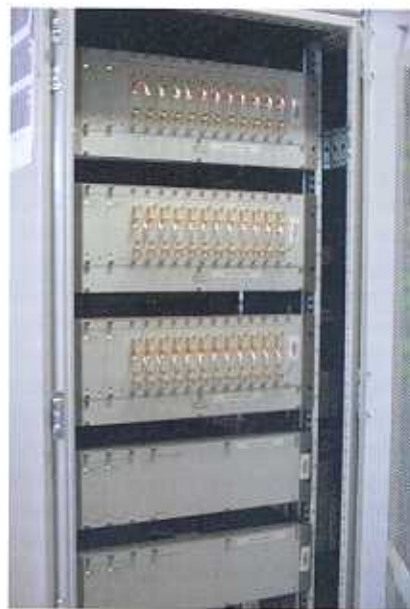
L-Band-Signalverteilungssysteme DEV 2180 und DEV 2190 bieten in einem Chassis von nur 4 HE Platz für bis zu 16 Verstärkerkarten an der Frontseite. Die Verteiler bzw. Matrix-Schalter befinden sich an der Rückseite.
